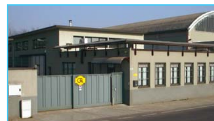
I capannoni di via Edison
